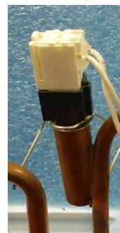
Sonde ventilateur (CN13) :
