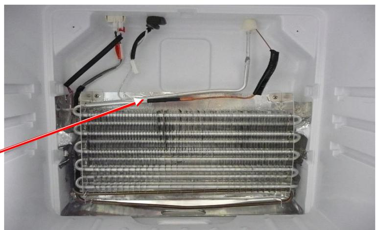
Ensemble évaporateur, fusibles thermiques et résistance de dégivrage
